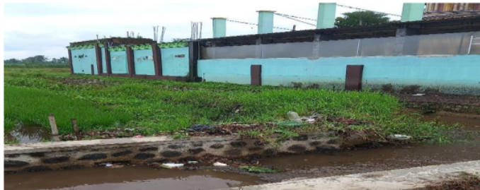
Gambar 7 Kondisi irigasi yang tercemar sampah
