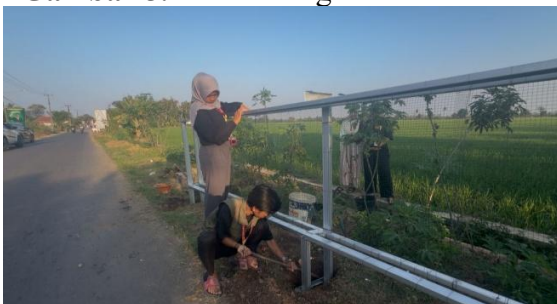
Gambar 7. Proses Pemasangan Kerangka
