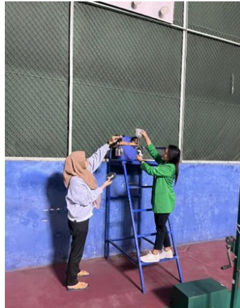
Gambar 3. Penggantian Nomor yang telah rusak.
